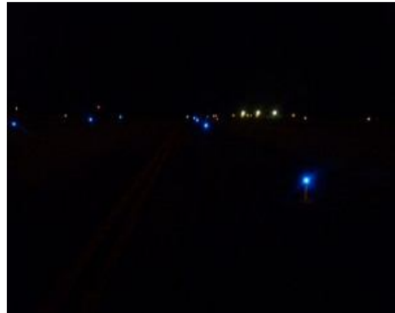
Figura 6 - Luminária LED (vista noturna)
